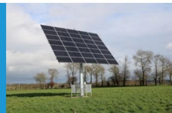
**Les trackers solaires, appelés également “suiveur solaire”, sont des systèmes de mât ancré au sol, articulé sur 1 ou 2 axes qui permettent aux panneaux de suivre la course du soleil.**
