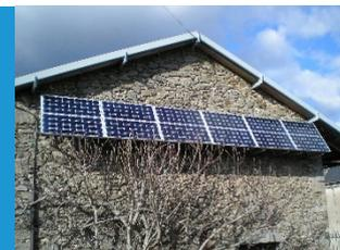
**Ces kits sont constitués d'un ou plusieurs panneaux en fonction de la puissance, d'un onduleur et d'une structure permettant de les installer au sol, sur le pignon d'un bâtiment ou autre.**
